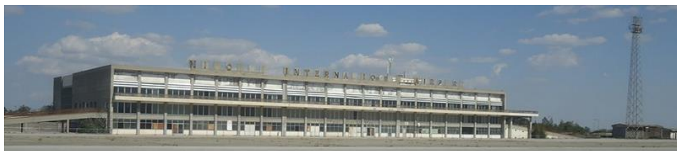
Εικ. 11 Το παλιό τερματικό στη σημερινή του κατάσταση (Λιασιδής Σ. 2014)
