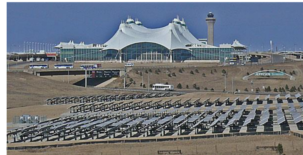
Εικ. 8 Φωτοβολταϊκές εγκαταστάσεις στο Διεθνές Αεροδρόμιο του Ντένβερ (www.worldwatersolar.com).
